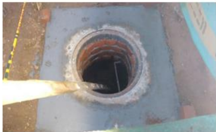
Construcción pozos de inspección
