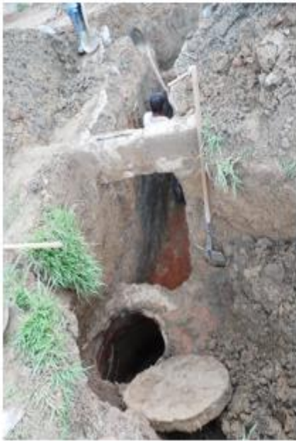
EXCAVACION DE POZO A CONSTRUIR A POZO DE DESCARGA EXISTENTE
