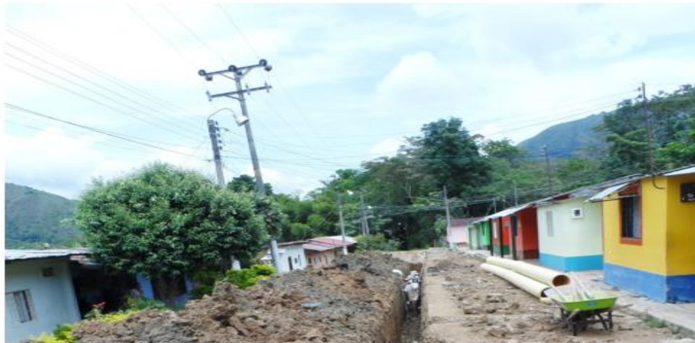
EXCAVACION PARA INSTALACION DE TUBERIA DE 12"
