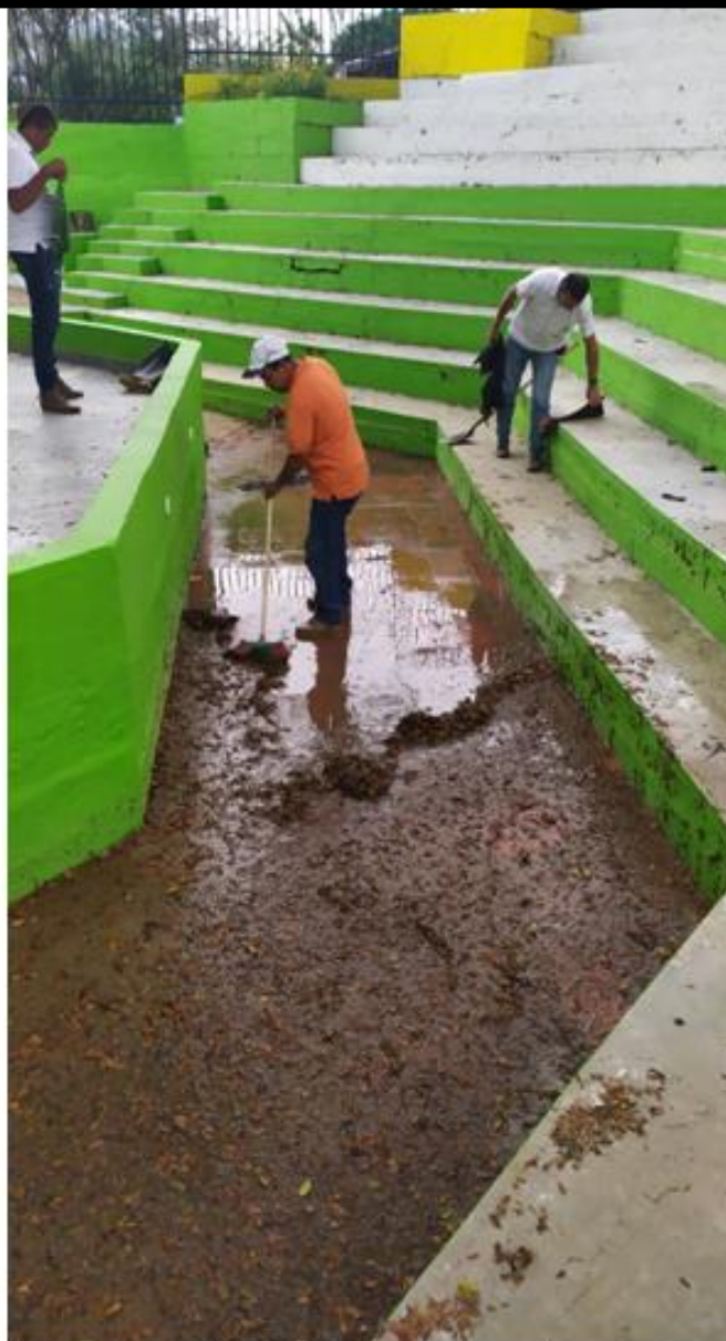
Limpieza sistema de aguas lluvias en la Concha Acústica
