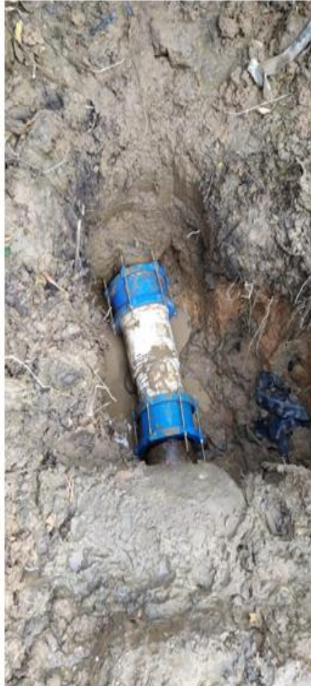
Reparación tubo de 10" que alimenta el tanque de almacenamiento en la planta de tratamiento
