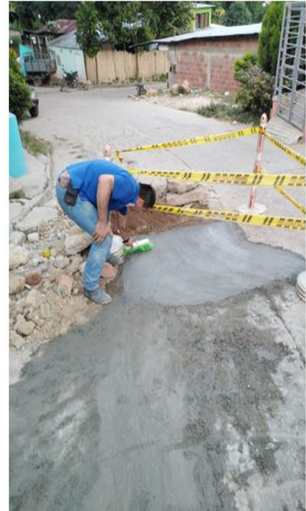
Reparqueo en la Calle 10 con Carera 1 por daño de alcantarillado
