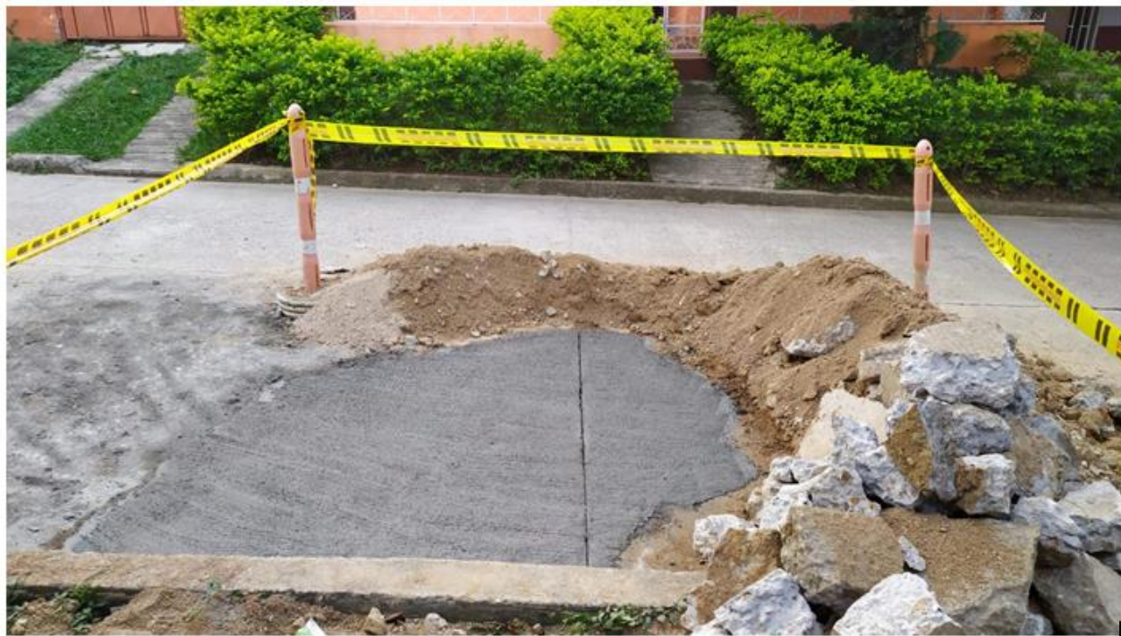
Reparqueo en la Carrera 8 entre Calles 4 y 5 por daño de alcantarillado
