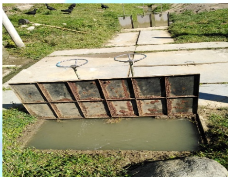
Salida de Tanques Desarenadores
