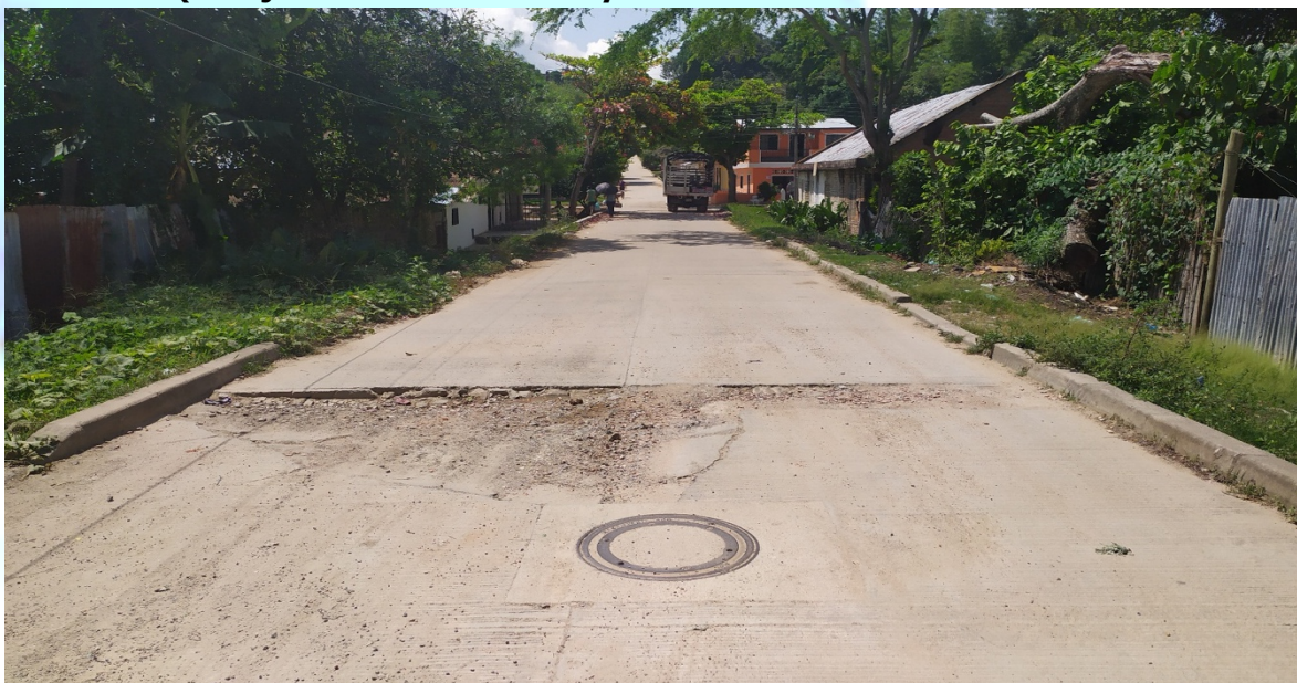
Reposición placa en concreto de la canalización de la Calle 10A Barrio Miraflores (Callejón entre las Calles 10 y 11 donde vive Rosalba Barrero)
