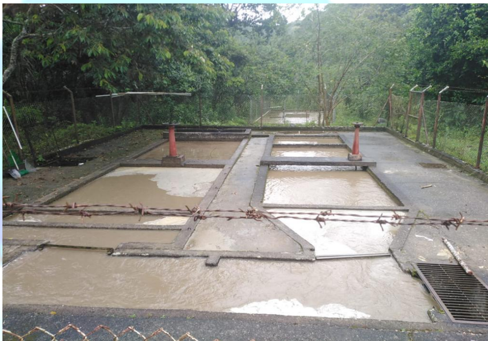
Sección 1 desarenador y sedimentadores
