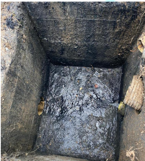
Adecuación de caja a pozo de inspección
