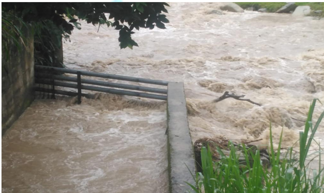
Captación Río Luisa
