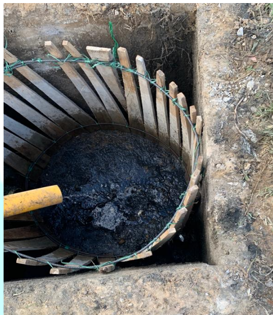
Adecuación de caja a pozo de inspección
