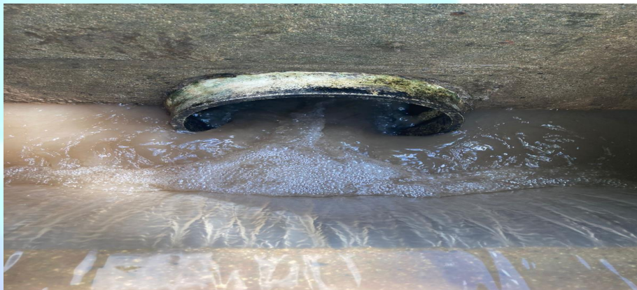
Tubería de 12 pulgadas
