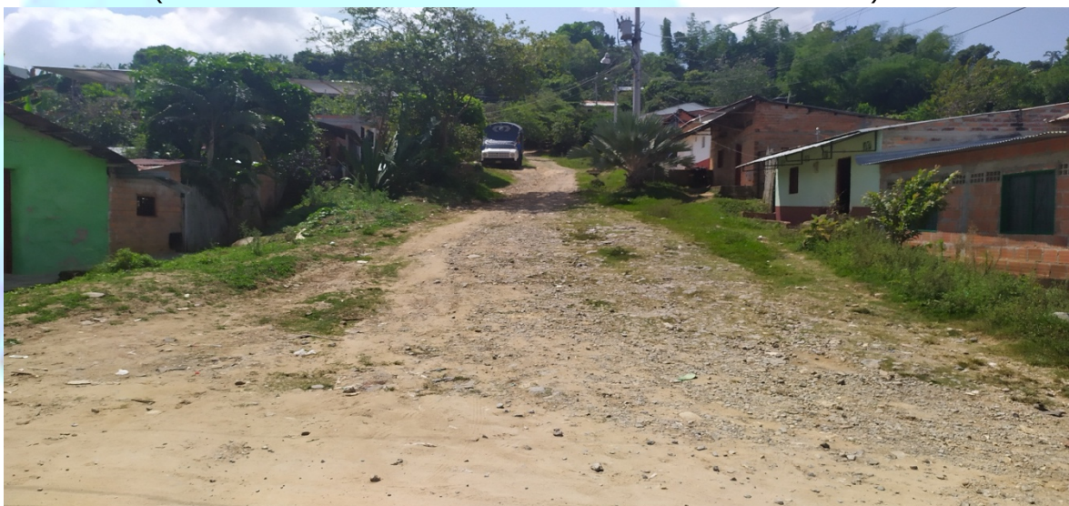
CARRERA 8 ENTRE CALLE 7 Y CALLE 8 Barrio Antena 80 ML (Calle de Rosco)
